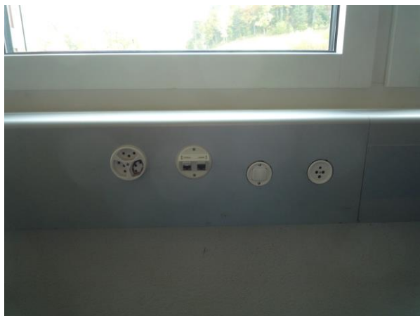
Bestehende Brüstungskanäle Schulungsgebäude B
