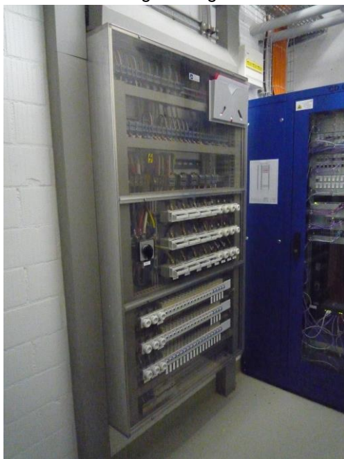
UV 1.2 im UG (Einspeisung ab Geb. C)
