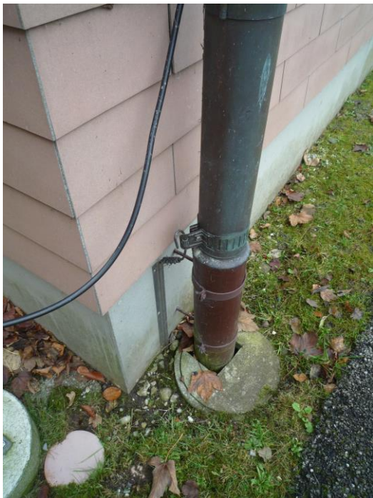
Beispiel Dachwasserfallstrang als Ableitung
